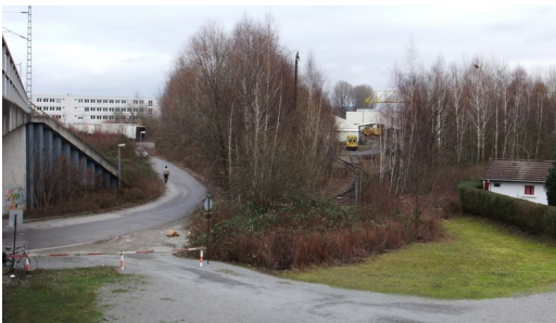
Als div. Brücken der Strecke KA–Graben-Neudorf saniert wurden, war der alte Güterbahnhof an der Kriegsstr. noch im Betrieb, so dass auch die Brücke links gebaut werden musste. Jahrzehnte später soll von rechts kommend am Gleisbahnhof vorbei (Hintergrund rechts) die S31/S32 hier durch und über den Ostring; Das der Realisierung am nächsten stehende Projekt 1.12 der „Netzkonzeption 2020/2030“, s. a. S. 12; Foto 2012: H. Jacobs
