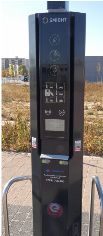
Ladesäule steht noch vor den Häusern im Neubaugebiet; F.: H. Jacobs
