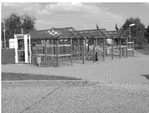
Fahrradparker an der Haltestelle Oberderdingen-Flehen an der S4 mit einem Einzugsgebiet von ca. 10.000 Einwohnern mit teils luxuriöser Anbindung an die Nachbarorte (nach Oberderdingen ist der Radweg z. B. beleuchtet, hat selbstverständlich Winterdienst und ist abschnittsweise mit Blendenschutz gegen die nahe Landstraße abgeschirmt. Man beachte die teils fehlenden Scheiben, die dem nächtlichen Vandalismus geschuldet sind.
