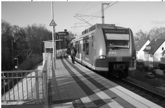
Germersheim-Mitte: Für die Stadtbahn (Gleise unten) gibt's richtige Anzeigen, für die S33 nur eine Billigversion
