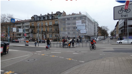
Auch die alte und durch Baustellen ramponierte Querung Hirschstr. wird leistungsfähiger; Foto: Heiko Jacobs
