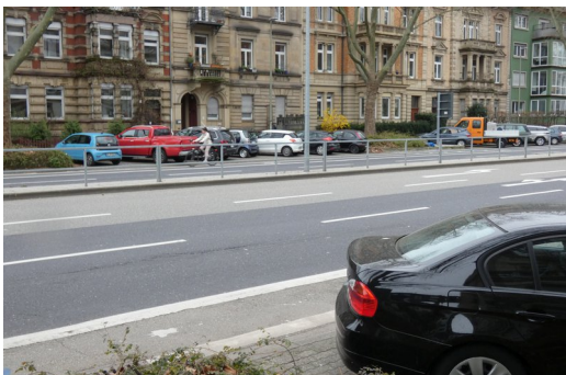
Die Schrägparker werden durch Längsparker ersetzt, die Radspur erhält deutlich mehr Breite und Abstand zu den Parkständen, die Sicherheit wird erhöht statt Gefahr heute; Fotos: Heiko Jacobs
