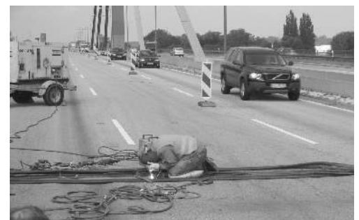
Oben: Einbau des Ersatzteils am Punkt der geringsten Belastung: zwischen den Spuren.
