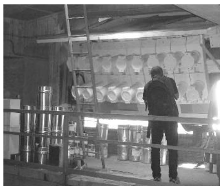
Das Ende der Seile im Inneren der Brücke.
