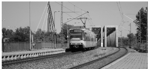
Die Alternative: Eisenbahnbrücke; Foto: Uwe Haack
