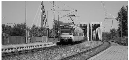
Die Alternative: Eisenbahnbrücke; Foto: Uwe Haack
