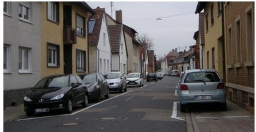
Auch so kann's werden: Ein Gehweg in voller Breite, der andere fällt komplett weg. Situationsbedingter, aber nicht unbedingt fußgängerfreundlicher Kompromiss ...
