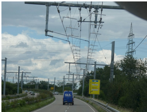
Blick auf die Fahrleitungsanlage aus dem Lkw heraus
