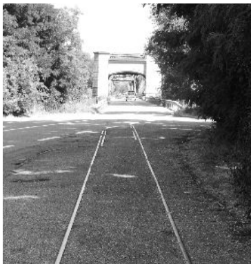
Auto statt Bahn: Wintersdorfer Brücke Foto: Heiko Jacobs
