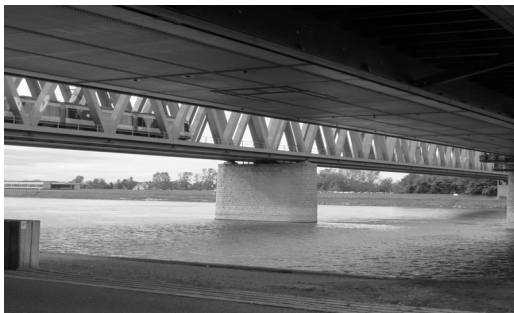
Bahnbrücke neben der 1. Autobrücke; Foto: Uwe Haack
