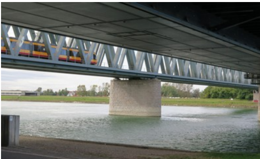
Bahnbrücke neben der 1. Autobrücke; Foto: Uwe Haack
